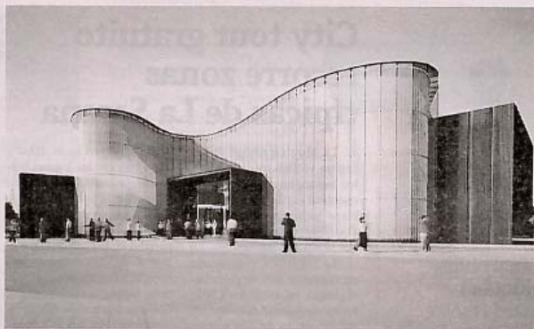
El pabellón tiene más de 2.500 metros cuadrados construidos, y tendrá un restaurante y cafetería.
